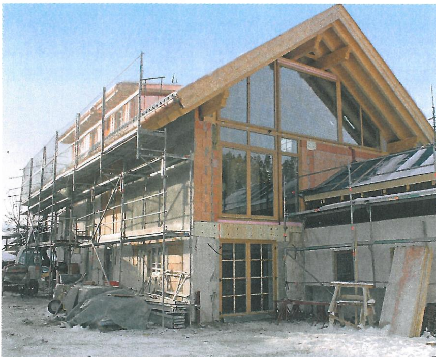
Die Nord-Ost-Fassade des ehemaligen Heubodens wurde fast vollständig bis in den Dachfirst hinauf verglast. Ein Wohnerlebnis der besonderen Art!
